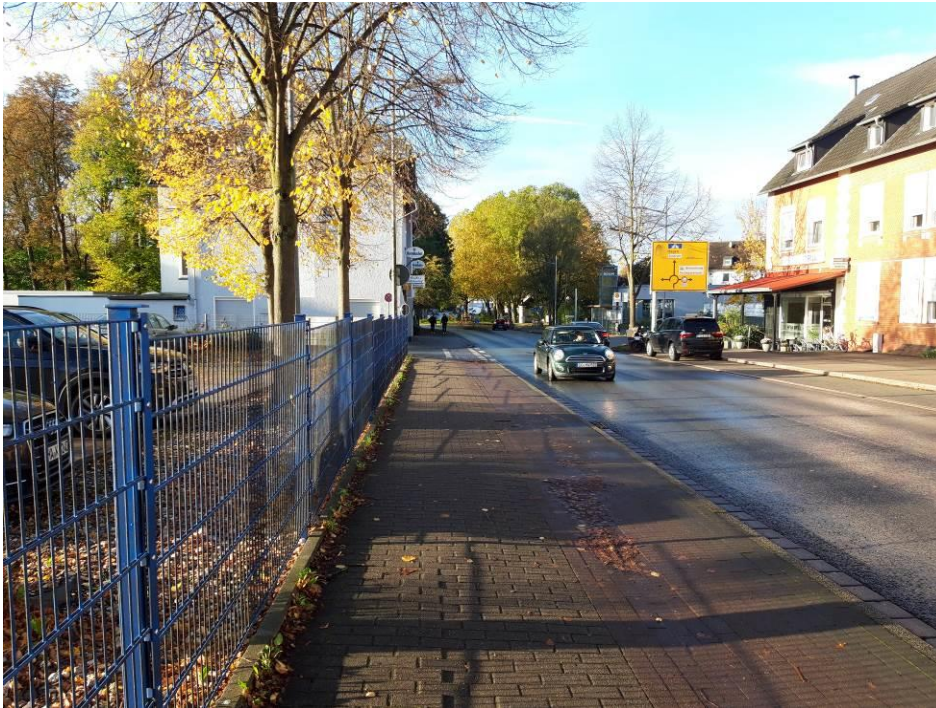
Abb. 6: Blick entlang des geplanten LWL-Kabels an der Schützenstraße
